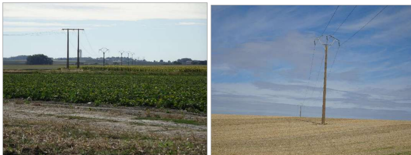
Photographie 16 : Ligne à Haute Tension traversant la ZIP (Source : ENCIS Environnement)
