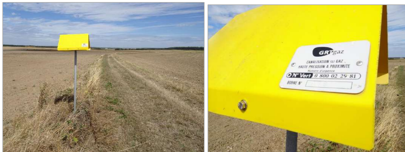
Photographie 17 : Signalétique de la conduite de gaz à haute pression (Source : ENCIS Environnement)
