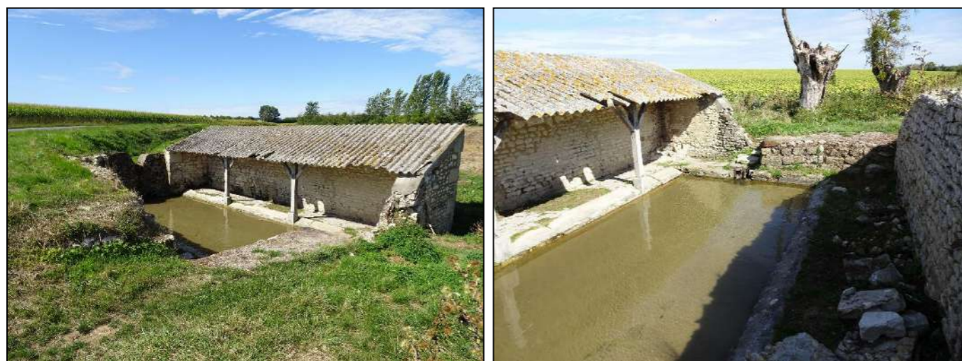
Photographie 7 : Lavoir et Fontaine de Braizé au sud-est de l'AEI (Source : ENCIS Environnement)
